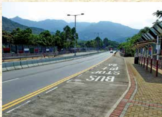
改善工程第一期，擴闊車道並加建隔音屏障。
