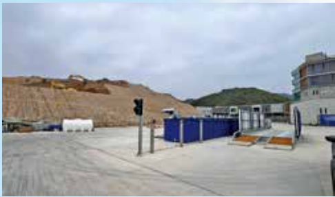
現時第137區有填料庫等公共設施。
