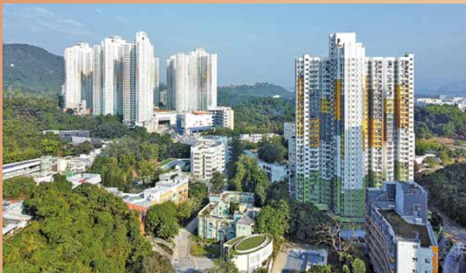
富蝶邨近月火警鐘頻繁誤鳴，惹起居民關注。
