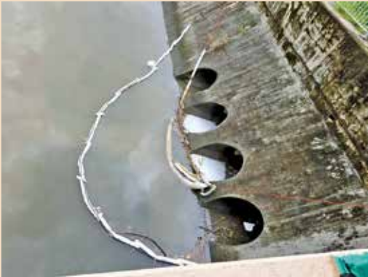
署方在排水口設置隔油條，以攔截泡沫並即時清理。 渠務署接報後在出水口安裝鏡頭監察。
