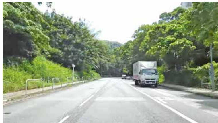
富健街是一條三線車路，部分路段屬斜路。
