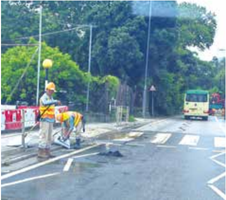
工人緊急修補河上鄉路路面的坑洞。
