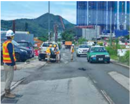
工人緊急修補河上鄉路路面的坑洞。
