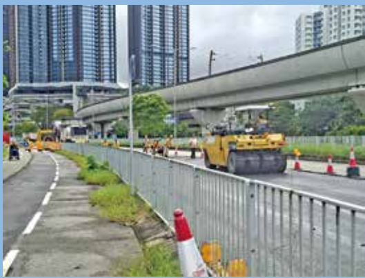
8月2日，工程人員加緊修復消防水喉爆裂。
