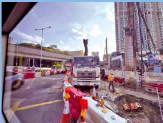
車公廟路8月9日因水管維修要緊急收窄車道。
