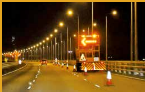
天色黑暗，在公路進行維修工程的人員風險增加。（路政署圖）
