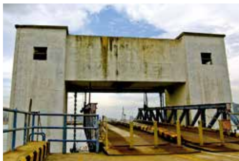
門框式建築配合雙層汽車渡輪的營運。
