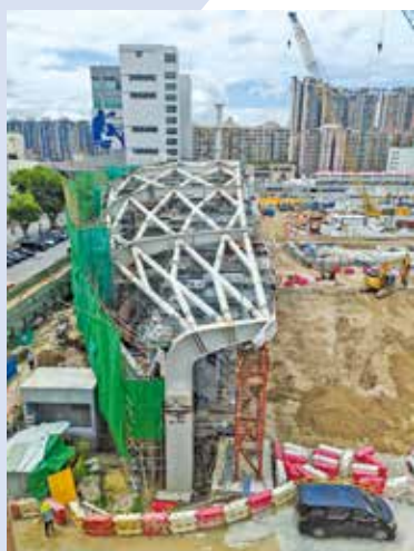
球場兩邊看台的主體鋼結構已安裝成形。
