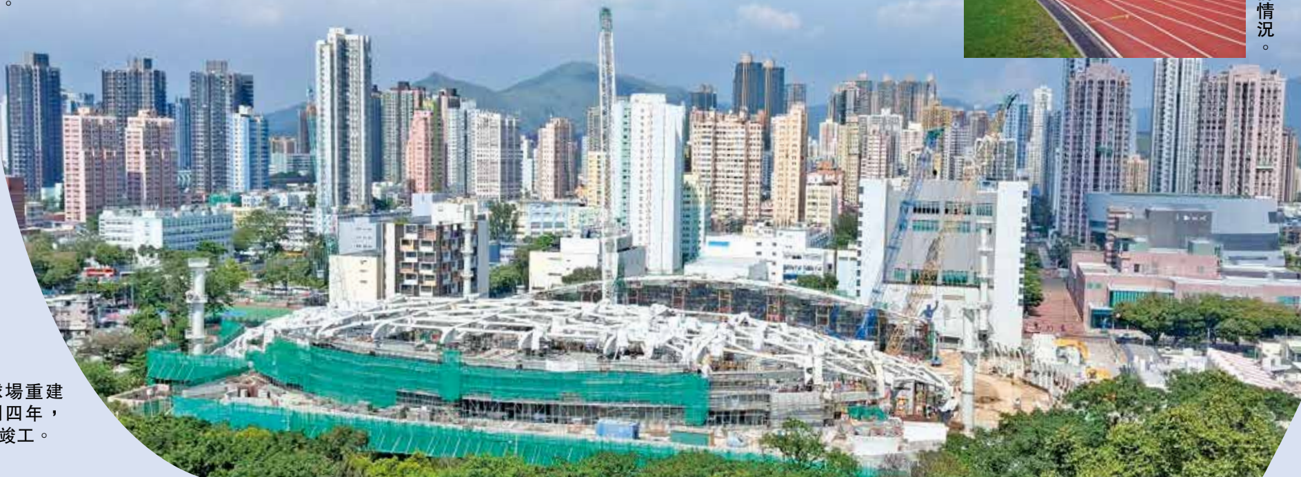
球場兩邊看台的主體鋼結構已安裝成形。
