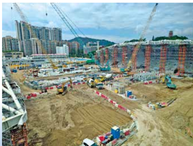
施工方加快進度，有望於2026年底完成。
