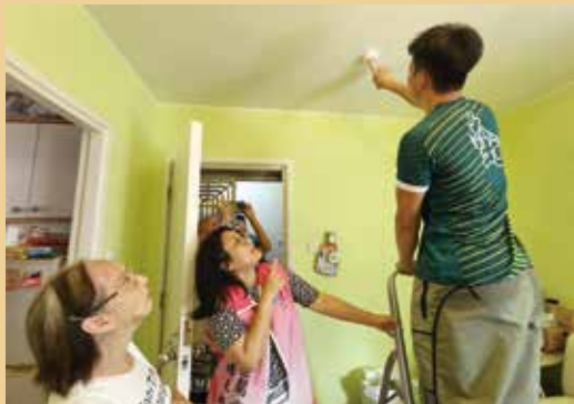
消防員為有需要住戶檢查電力裝置。
