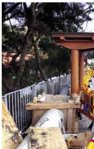
環保大道即將開展更換水管工程。
