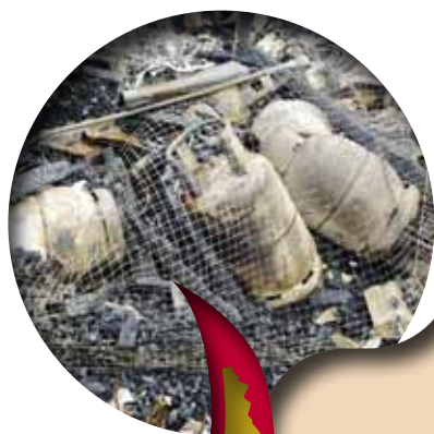
現場有不少 易燃氣罐。
