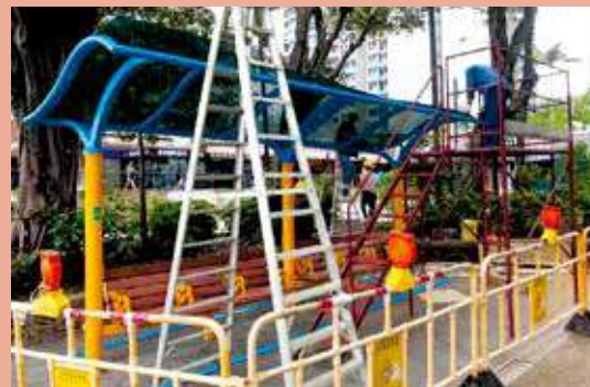
天耀邨的休憩設施，趁著疫情期間，進行維修工程。
