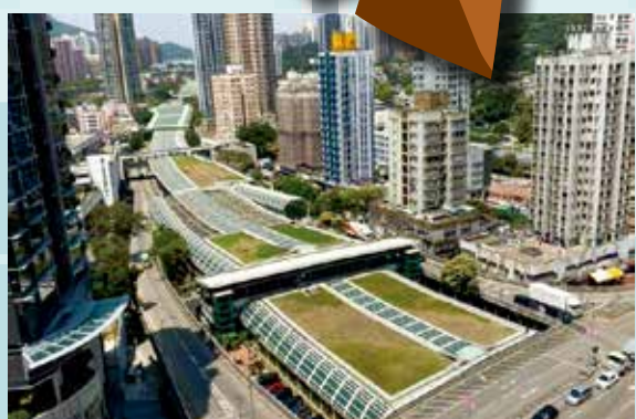
屯門公路市中心段加設綠化上蓋現況。(網上圖片)
