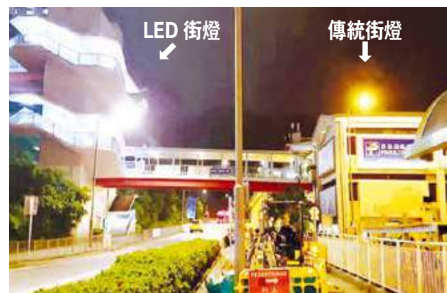
新LED路燈較傳統低瓦數的高壓鈉路燈更明亮、省電。
