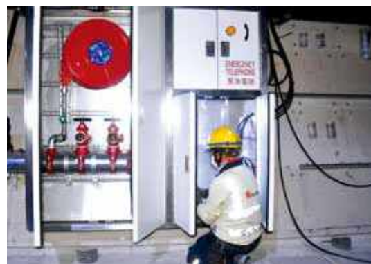
運輸署指北面連接路海底隧道工程仍在施工。
