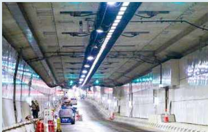
連接路屯門一端是五公里長海底隧道。
