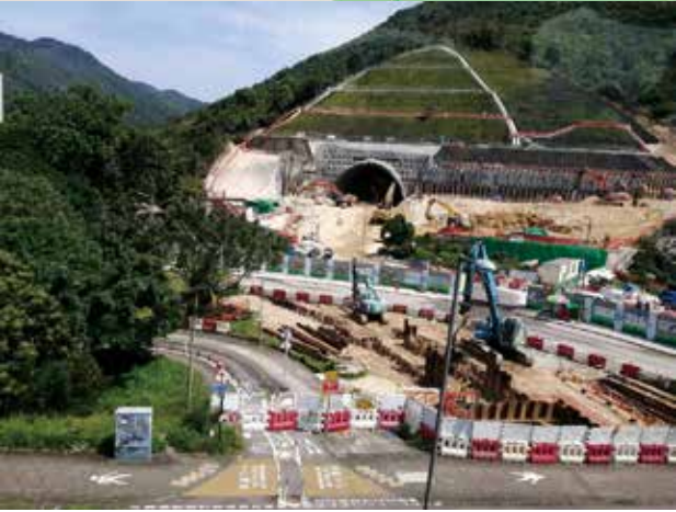
岩洞前期工程中隧道護土牆工序，早於今年初展開。
