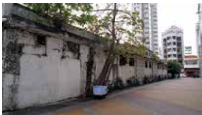
斜頂被階梯式護牆遮擋。
