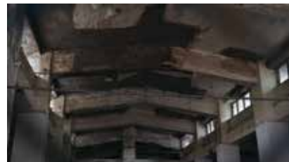
聯和市場內部用以支撐上方鋼筋混凝土天台的橫樑和樓板。
