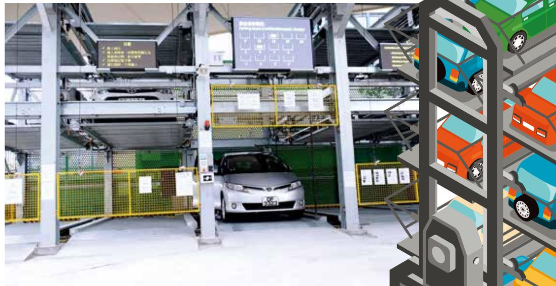
智能停車場部分泊位，將採用拼圖型自動泊車系統。（構想圖）——運輸署指採用自動泊車系統，停車場泊位可增加至少三成。
