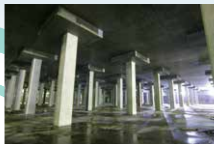
蓄水池可在豪雨時將雨儲起避免水浸，圖為大坑東蓄水池。
