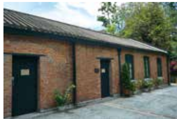
瓦頂下更裝有簷板（木板）用作擋水。
