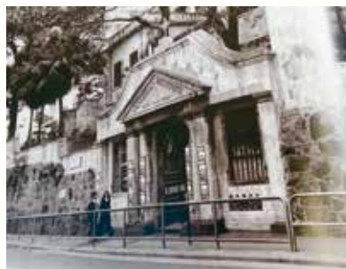
屯門馬禮遜樓舊貌。
