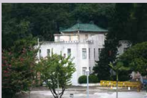
屋頂鋪上青釉中國式瓦片，有兩層被髹上紅漆的挑出椽子。
