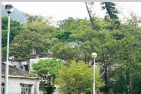
屋頂為塔樓式結構。
