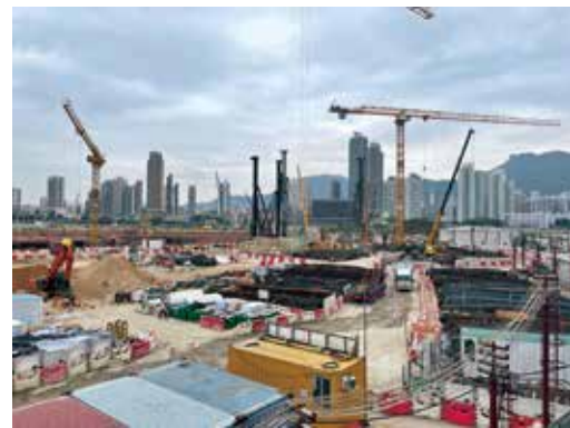
啓德體育園年底可開展上蓋工程。
