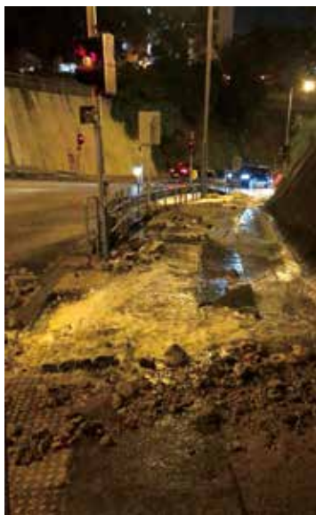
葵涌大窩口道近石頭街，上月亦有鹹水管爆裂。
