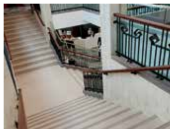
兩旁設有一條裝飾鐵製扶手的樓梯。
