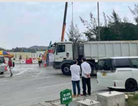
大批工人趕工組裝，務求令設施盡快交付。
