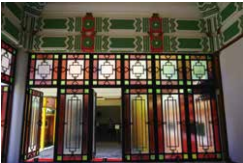
主樓旁的廊屋，內裡每個窗框形狀均不相同。
