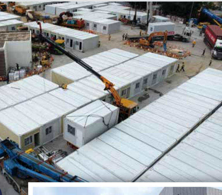
隔離設施以貨櫃單位組成，工人正將貨櫃吊運。
