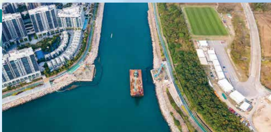
南橋將橫跨東邊水道，水道兩邊地基工程已展開。
