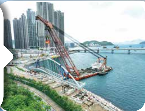
③移送至位於日出康城南海濱長廊旁的臨時工地，待稍後安放在橋墩。
