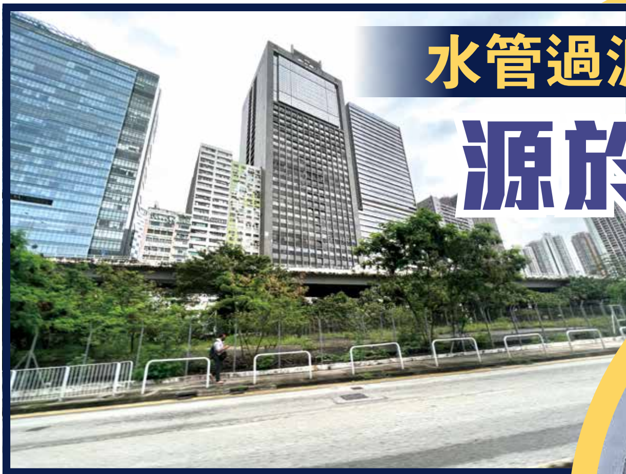
荃灣海興路「水管屋」延誤逾兩年仍未動工。
