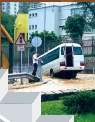
荃灣西樓角路爆水管，有小巴被困水中。
