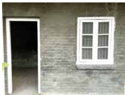
車站當年的木門及木窗框，仍原封不動。
